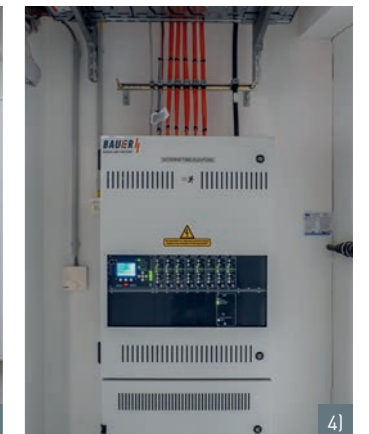
1) Flur zu den Hörsälen 2) Bedienfeld Sicherheitsbeleuchtung 3) Steigtrasse E30 u. Schwachstrom 4) Sicherheitsbeleuchtungszentrale Bilder: © BAUER
