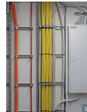
1) Flur zu den Hörsälen 2) Bedienfeld Sicherheitsbeleuchtung 3) Steigtrasse E30 u. Schwachstrom 4) Sicherheitsbeleuchtungszentrale Bilder: © BAUER
