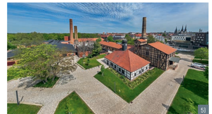
1) Halle Nord mit Salzlabor und Schausiedern 2) Das moderne Touchpanel ermöglicht eine komfortable Steuerung der Beleuchtung. 3) Der Konferenzraum erstrahlt durch energieeffiziente Lichttechnik, die eine angenehme Atmosphäre schafft. 4) Flur mit Aufputzinstallation – wartungsfreundlich, sicher und schonend zur Bausubstanz 5) Luftaufnahme des „Saline-Ensembles“ | Bilder: © BAUER
